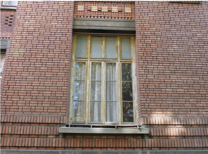
Variations ponctuelles du calepinage de briques
