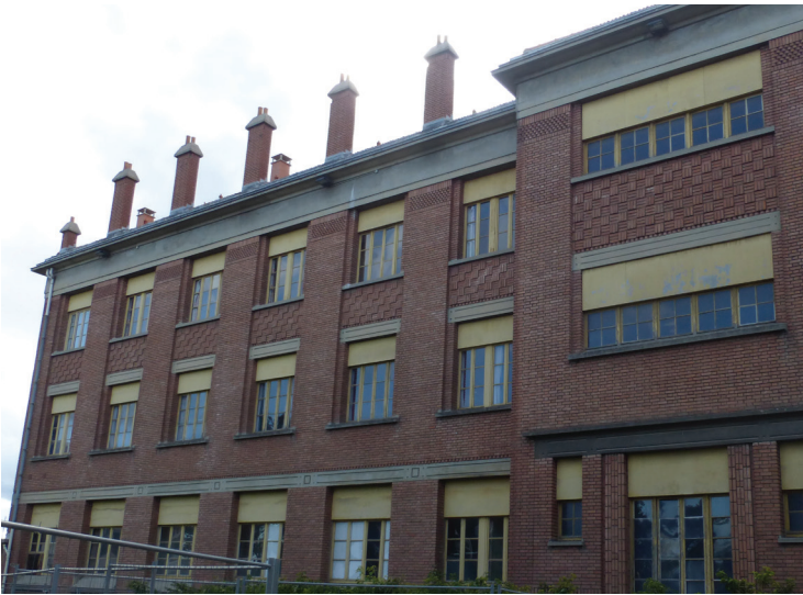
Détail des panneaux extérieurs sur les parties hautes des baies vitrées (B8)
