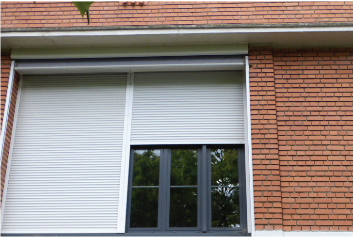
Détail des menuiseries métalliques remplacées
